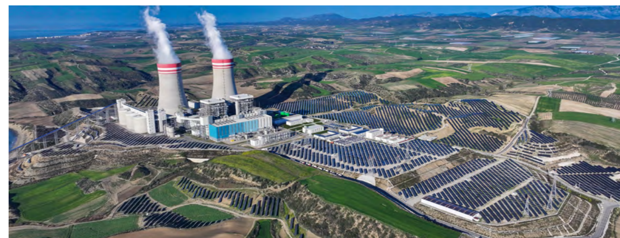
国家电投土耳其胡努特鲁电厂一期光伏发电项目 SPIC Phase I PV Power Project of Hunutlu Thermal Power Plant in Türkiye
