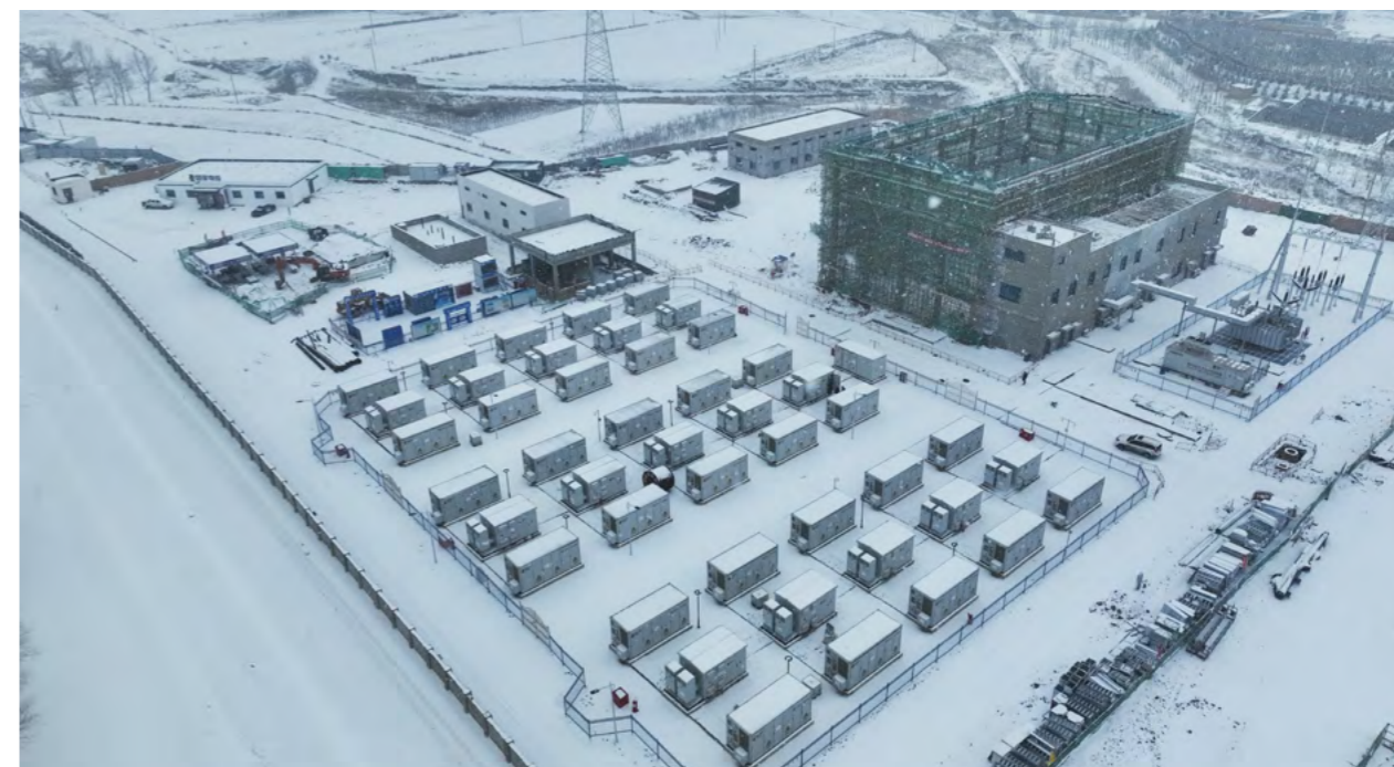
国家电投甘肃通渭县压缩空气+锂电池组合式网侧共享储能电站创新示范项目
