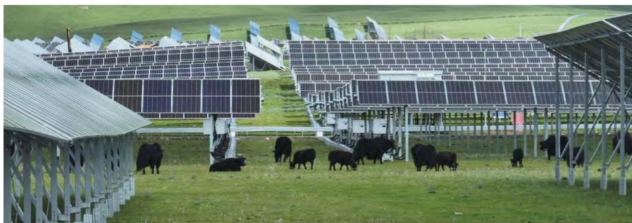
国家电投四川兴川实证光伏电站平均海拔约 4000 米，填补了我国光伏实证基地在超高海拔、中纬度地区的空白，是全球首个超高海拔光伏实证实验基地项目
